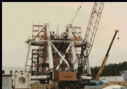
下部機器室の組み上げ
