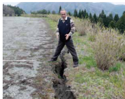
星の村天文台の第二駐車場。斜面との境界に亀裂が入り、滑落の危険があるため、現在は封鎖している。どのように復旧させるか、まったく見通しが立たないとのこと。
